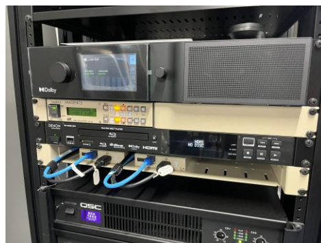
Dolby製シネマプロセッサー（上段）とQSC製アンプ（下段）
