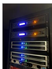
アンプ架内に設置された CODA「LINUS14」
