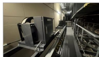
限られたスペースに設置された軽量コンパクトな電動三点吊りマイクウィンチ
